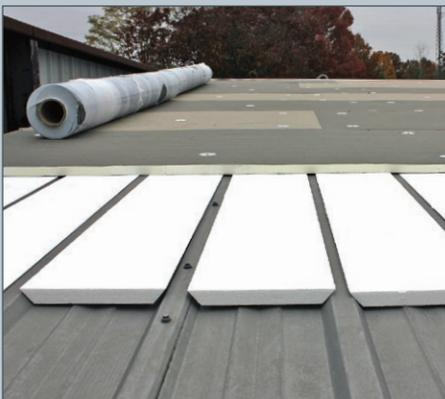
RhinoBond es además una opción ideal para aplicaciones de acondicionamiento de techos metálicos. Debido a que el sistema no requiere fijación a solape, no es necesario ubicar los solapes de las membranas encima de las correas. Por lo tanto, no es necesario utilizar láminas especiales del ancho de las correas, lo que facilita la instalación y reduce los desechos.
